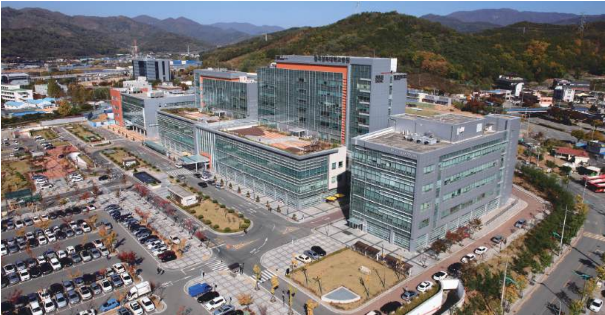
칠곡경북대병원, 암센터 및 노인의료시설 위치:대구광역시 북구 학정동 474 / 발주처: 경북대학교 / 공사기간: 2007.03~2010.07
