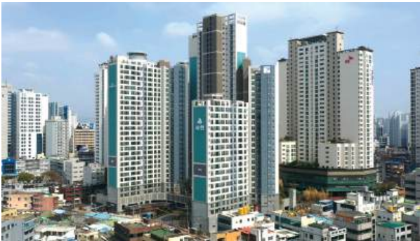
반월당역 서한포레스트 위치:대구광역시 중구 남산동 규모:총 427세대(아파트 375세대, 오피스텔 52실) 공급:아파트 전용 69㎡, 78㎡, 84㎡ / 오피스텔 전용 67㎡
